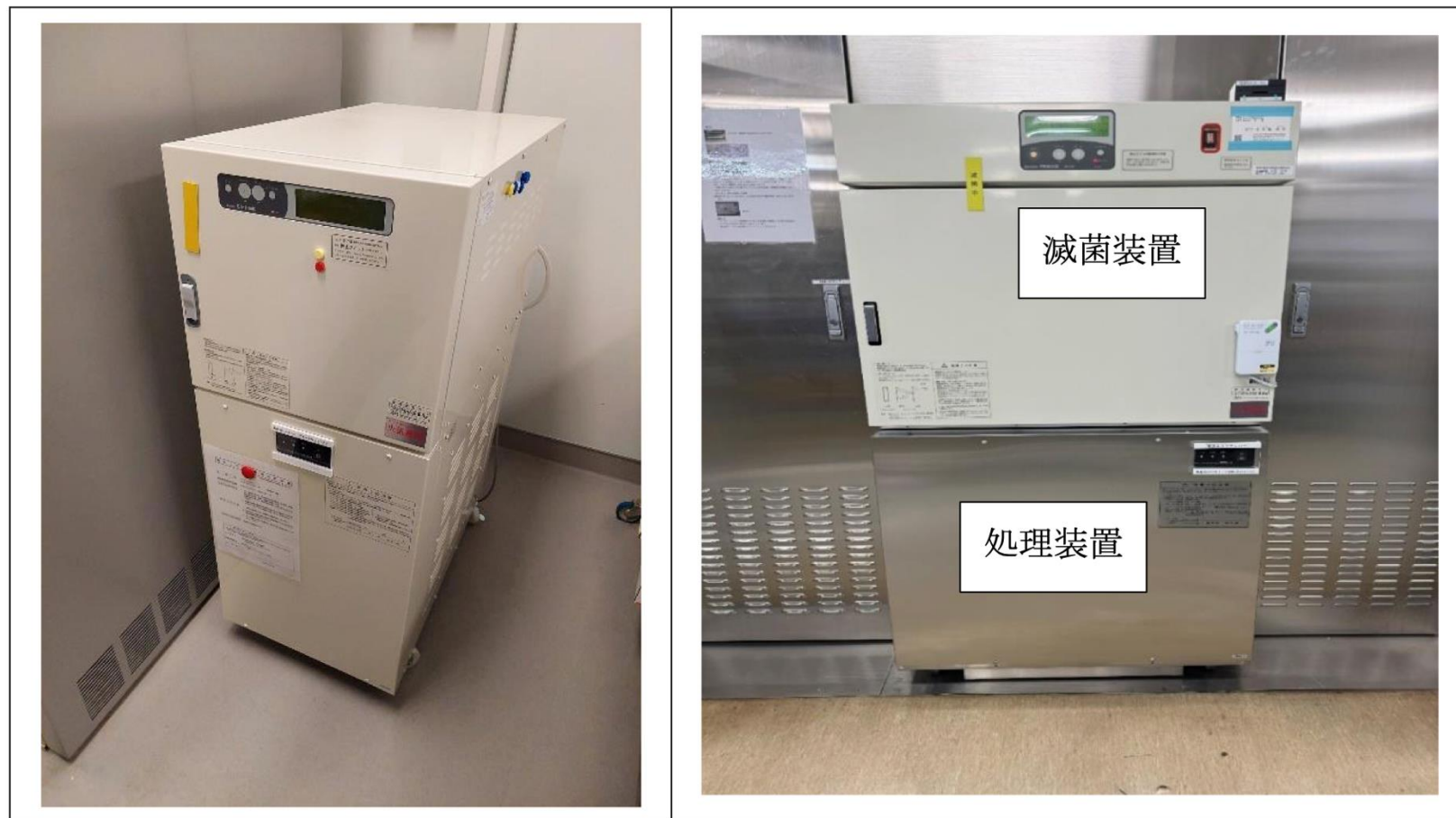
図 8 排ガス処理装置の設置例
